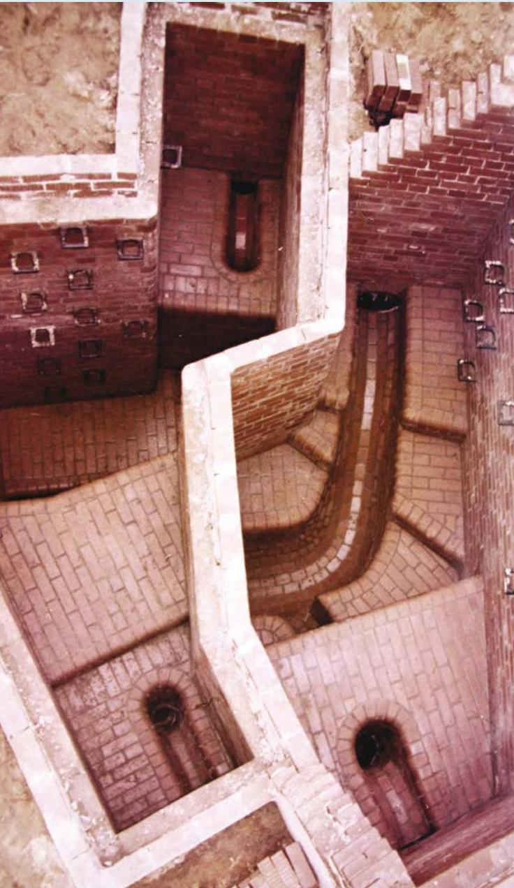
bleiben, nicht abheben, aber schon eine Unebenheit an der falschen Stelle, eine fehlerhaft berechnete Rundung im Rohr oder ein zu steiles Gefälle, können zu Verwirbelungen und Rückstau führen. Abwasser ist kein Quellwasser, es enthält Feststoffe, die hängen bleiben können. Ist der Durchfluss unzureichend, entstehen Ablagerungen.
