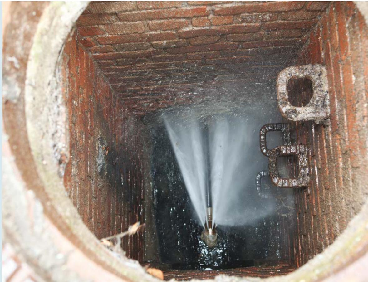
Der Düsenkopf des Hochdruckspülers arbeitet sich mit Wasserkraft durch den Kanal
