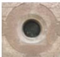
Die runden und rechteckigen Öffnungen an der zur Max-Ophüls-Platz gewandte Fassadenseite waren Teil einer Belüftungsanlage, die die Schulräume Ende des 19. Jahrhunderts mit Frischluft versorgte.
