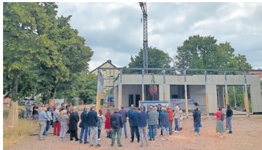
Der Rohbau der Bildungswerkstatt in Malstatt ist fertig, die Flachdachkonstruktion errichtet. Foto: Landeshauptstadt Saarbrücken
