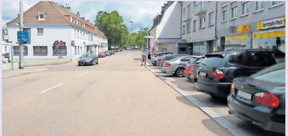
Vor der Umsetzung der Maßnahmen gab es in der Kepler- und Vorstadtstraße für Fußgängerinnen und Fußgänger keine sicheren Überwege und nur schmale Gehwege. Foto: LHS
